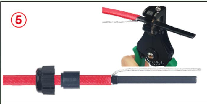
**5:** Retirar el aislamiento eléctrico del cable en la longitud requerida.
