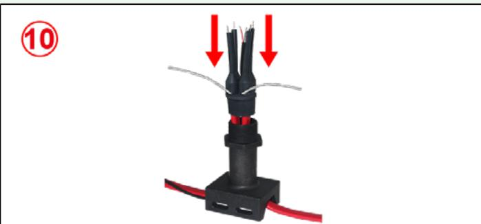
**10:** Deslizar las mangas aislantes sobre los conductores de los cables de calefacción, dejando el conductor de tierra afuera.
