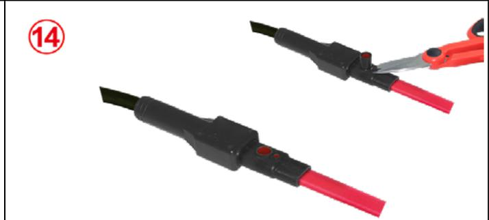
**14:** Después del curado, corte el embudo de llenado.
